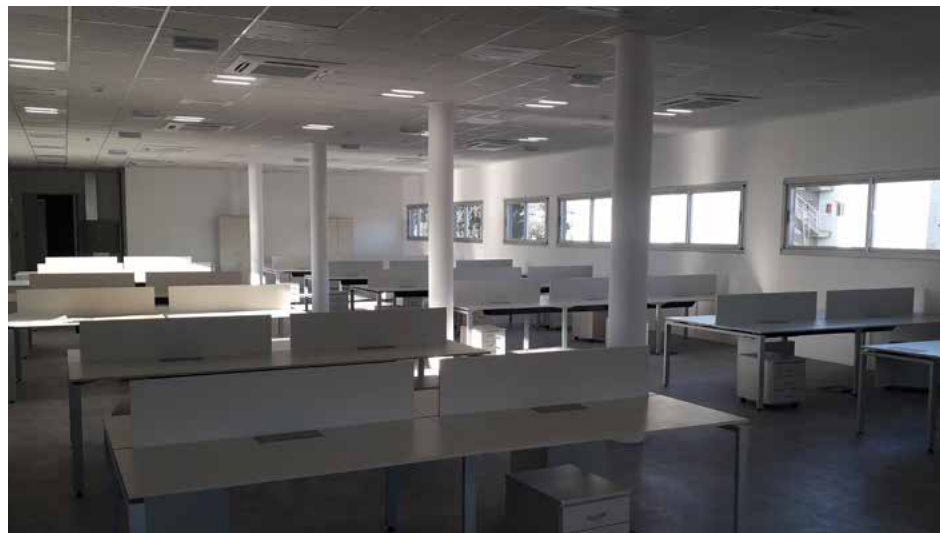
• Interior del edificio para la Gerencia de Sistemas, en construcción.
