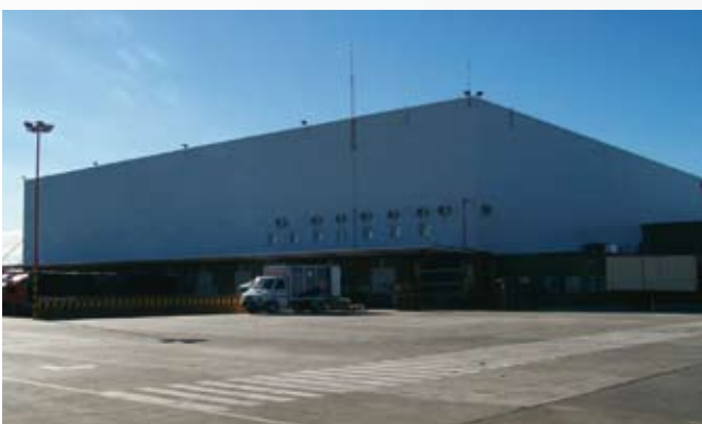
• Centro de distribución Bahía Blanca (Almacén).
