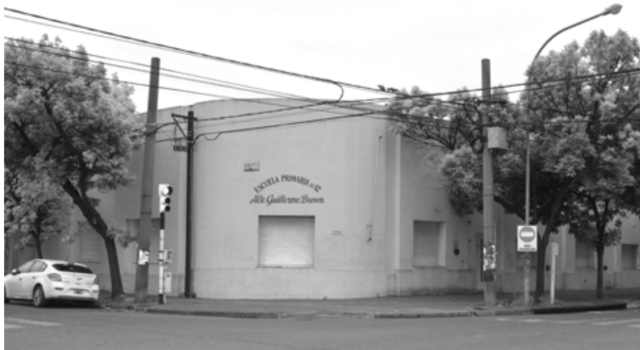
Vista de la Escuela N° 12 “Almirante Guillermo Brown”
