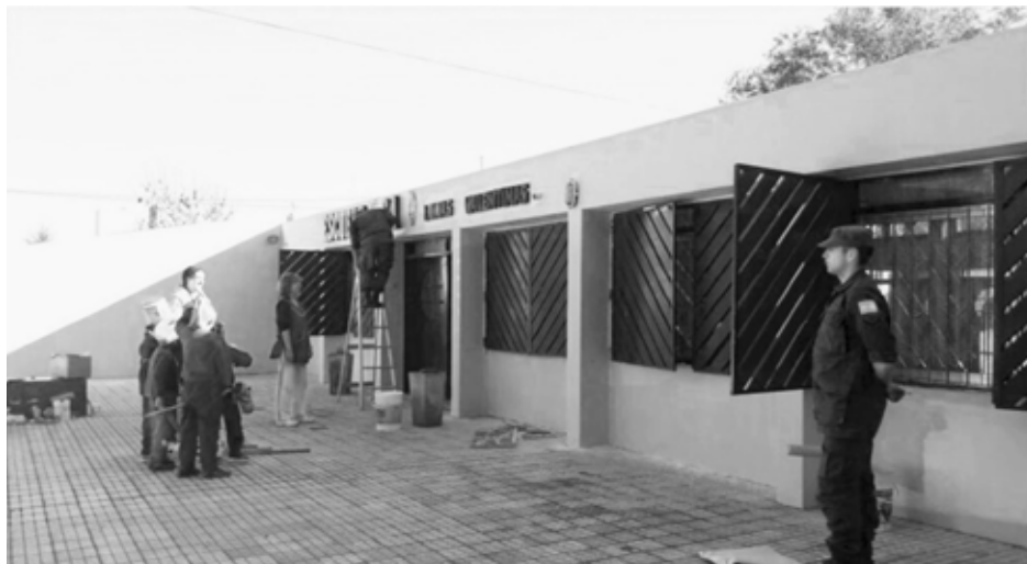
Suboficiales y soldados trabajando en 2010, en la restauración de la Escuela N° 64
